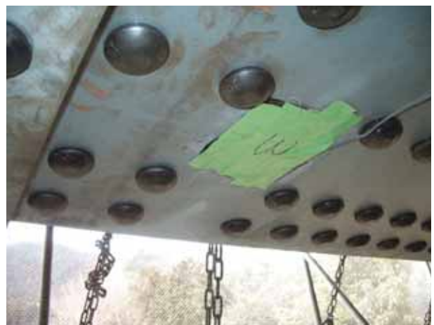
写真4 下フランジ補強板に取り付けた歪みゲージ
