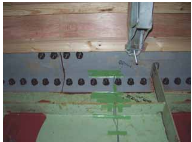
写真5 上フランジ補強板に取り付けた歪みゲージ
