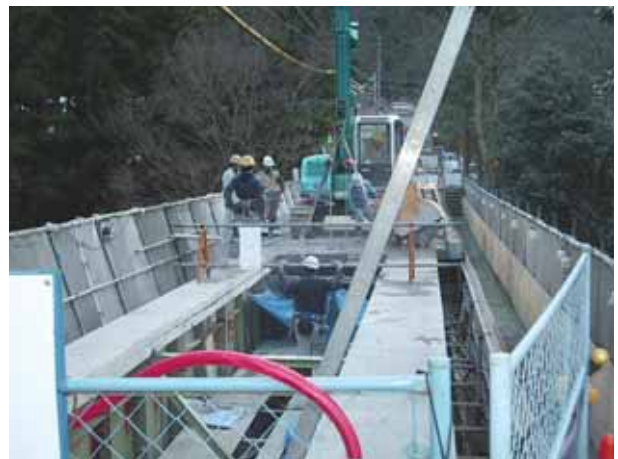
写真1 床版撤去状況
