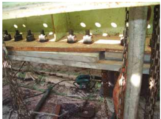
写真2 下フランジ補強板取付け状況(断面変化部)
