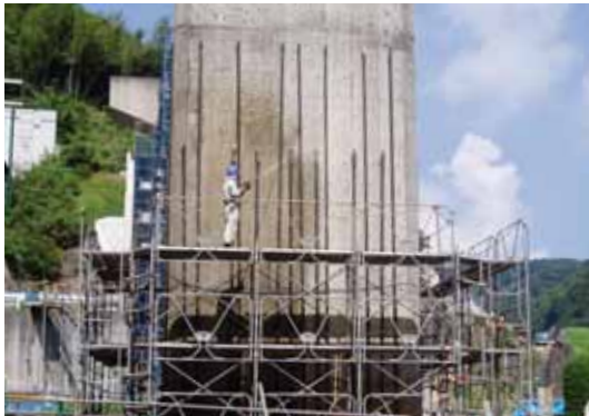
補強鉄筋建込み
