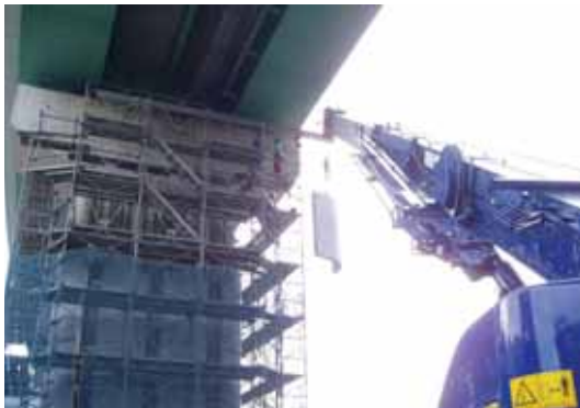
プレキャストパネル架設状況
