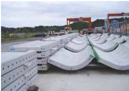
パネル仮置き状況
