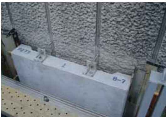
プレキャストパネル設置状況（コンクリート充填前）
