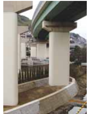
施工完了全景
