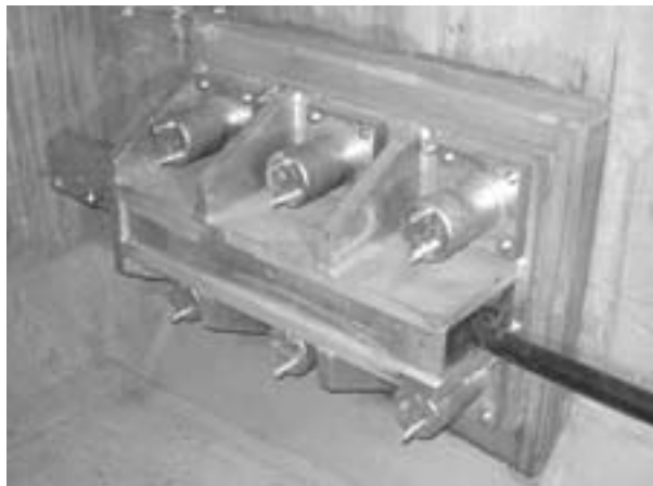
写真7 定着部(鋼製ブラケット方式)
