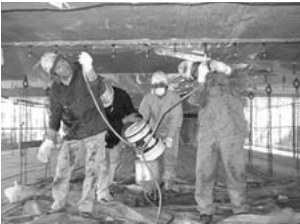
写真9 ひび割れ樹脂注入状況
