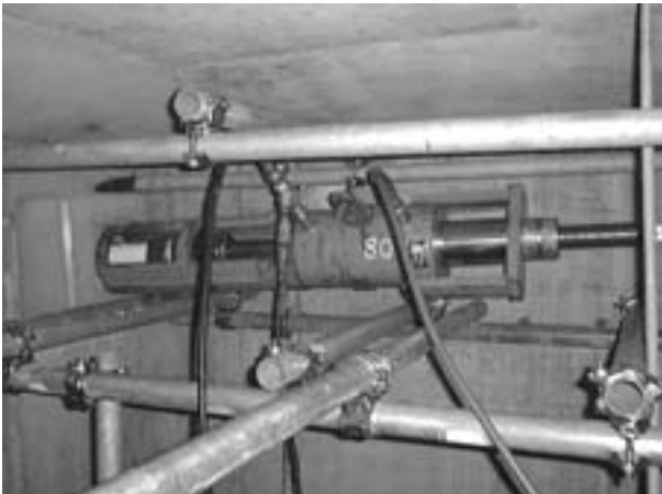
写真8 外ケーブル緊張状況
