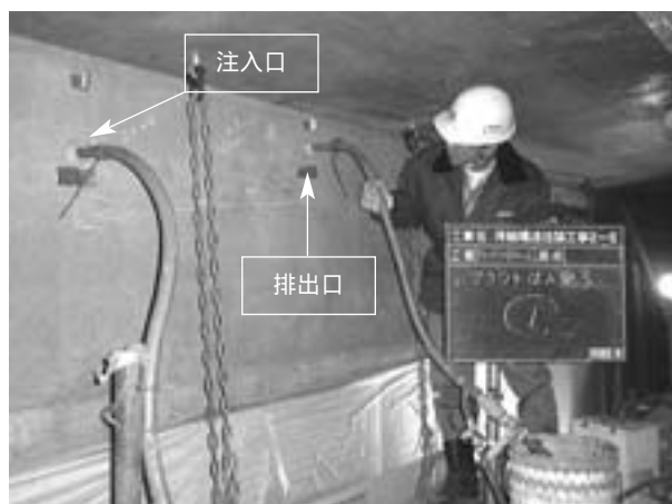
写真6 PCグラウト再注入状況(2穴式)
