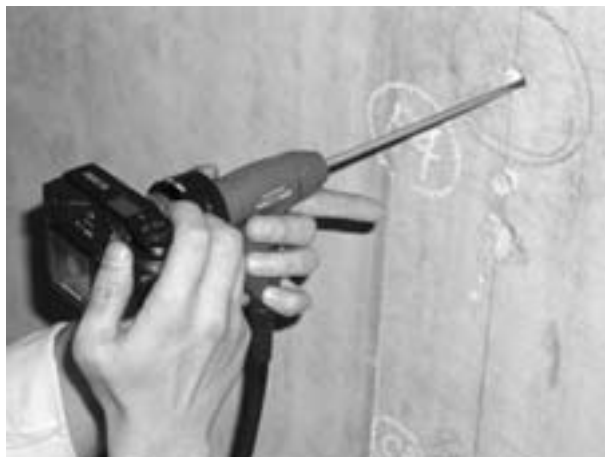
写真4 削孔目視調査
