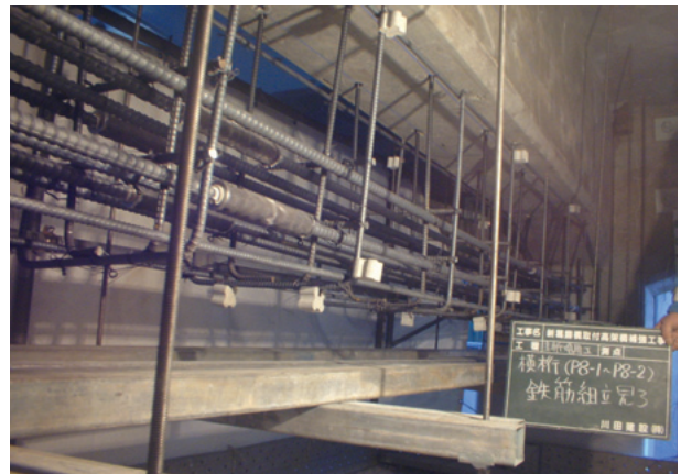
写真10 鉄筋、吊り型枠の設置
