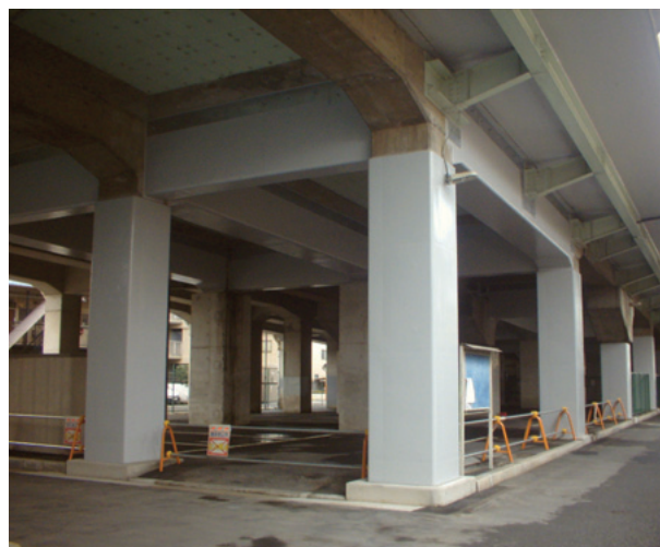
写真12 主桁、横桁増厚工完成
