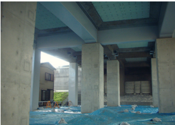
写真7 RC巻立て工完成
