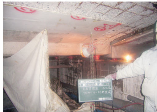
写真11 沓座コンクリート撤去 (ワイヤーソー切断)
