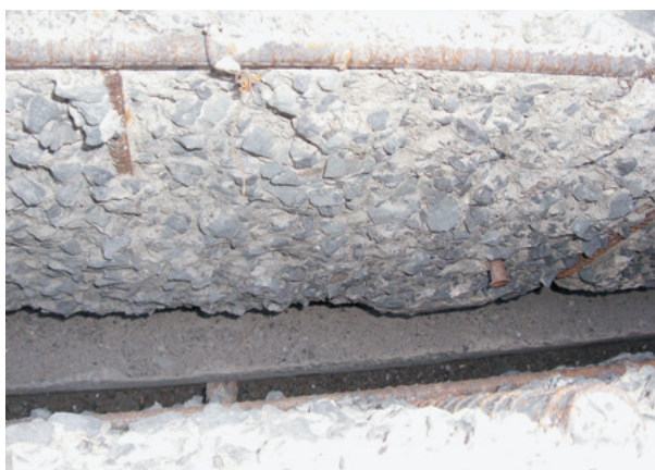
写真8 ウォータージェットによるはつり面
