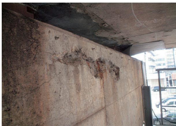
写真7 下部工天端付近の鉄筋腐食による剥離
