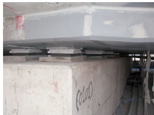
写真12 床版連結部支承取替完了
