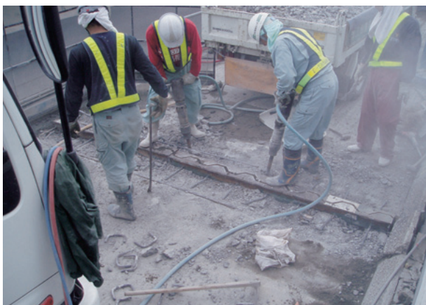
写真17 ブレーカーによる伸縮装置撤去状況
