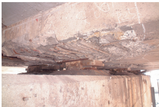
写真4 桁端部劣化状況（鉄筋腐食による剥落）
