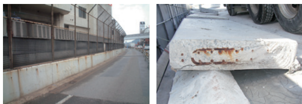
写真6 壁高欄鉄筋腐食によるひび割れ
