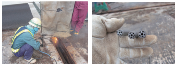
写真20 シャープランス切断とランス棒断面
