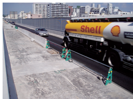
写真13 床版連結完了
