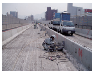
写真14 コア削孔
