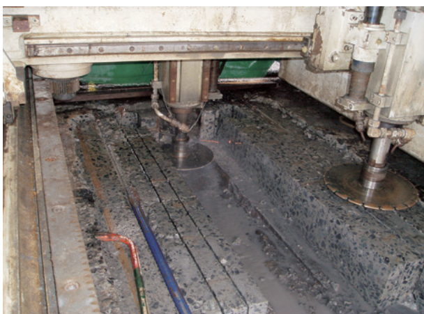
写真19 水平カッター切断状況
