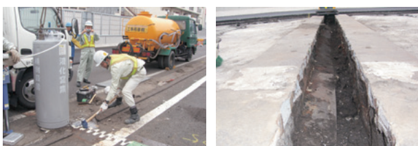
写真18 冷凍破壊およびフィンガー撤去完了
