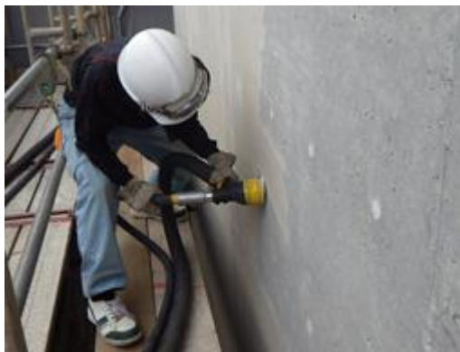
写真4 バキュームブラスト工法
