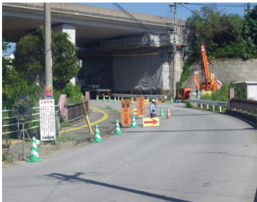
写真 6 A1-P1 径間部の市道交差状況
