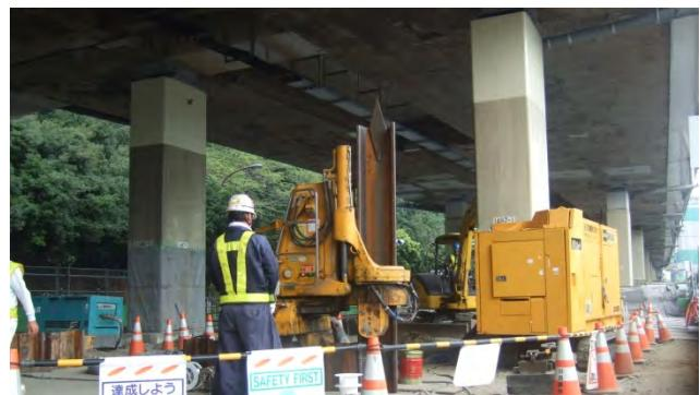
写真9 サイレントパイラーでの施工状況
