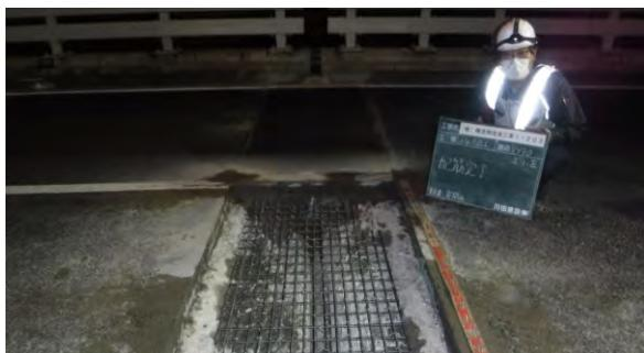
写真4 床版連結工施工状況
