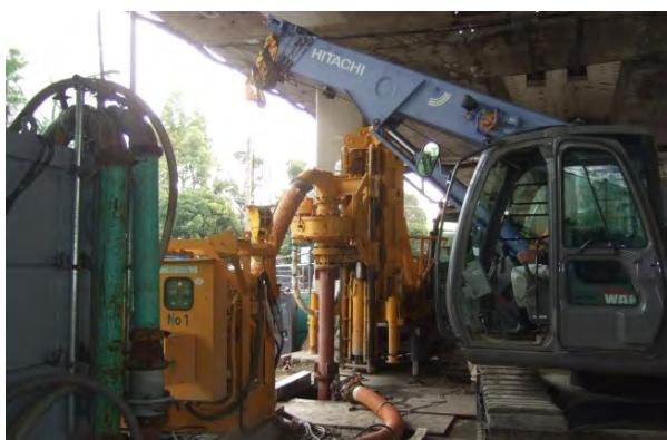
写真8 TBH工法での施工状況
