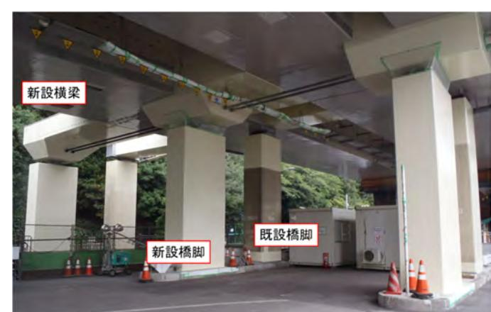
写真2 新設横梁・新設下部工 完成写真
