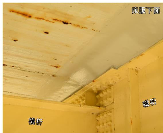
写真1 既設床版腐食状況
