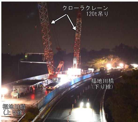
写真5 PC床版架設状況
