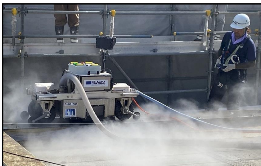
鋼桁ケレン装置システムによるケレン作業
