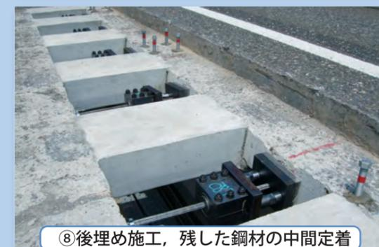
⑧ 後埋め施工, 残した鋼材の中間定着
