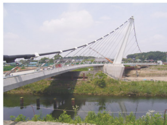
ケーブル引き込み完了後全景
